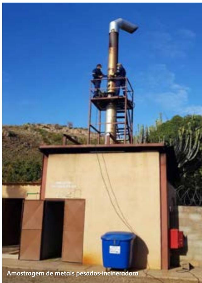
Amostragem de metais pesados-incineradora
